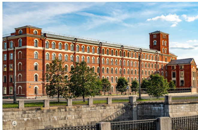
Наб. Обводного канала, д. 60
